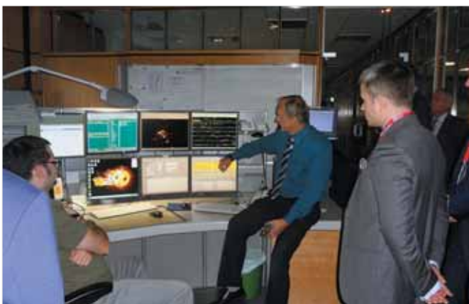
ЦУП S-Bahn на станции Берлин
