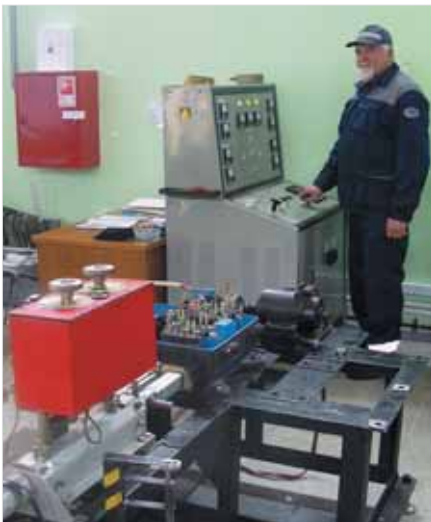
Старший электромеханик В.Н. Наумкин производит проверку и регулировку отремонтированного электропривода
