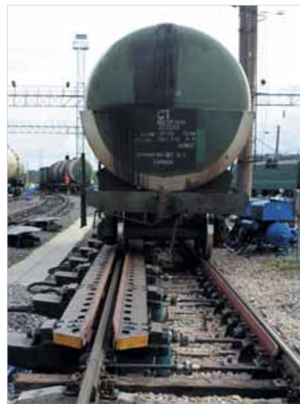
Замедлитель КЗПУ 600-5-1 на станции Новая Еловка
