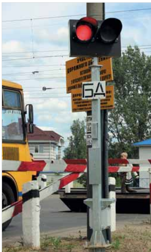
Новый светодиодный переездный светофор в едином полимерном корпусе
