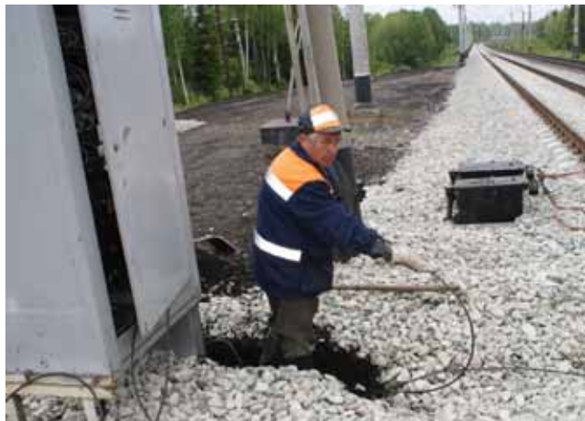
Электромонтер А.Д. Ковалев на монтаже сигнальной точки
