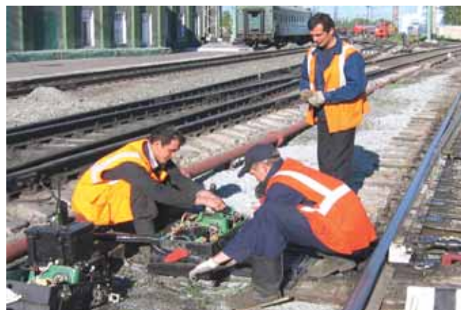
Братья Игорь и Владимир Вячистые заменяют стрелочный электропривод на станции Тайга
