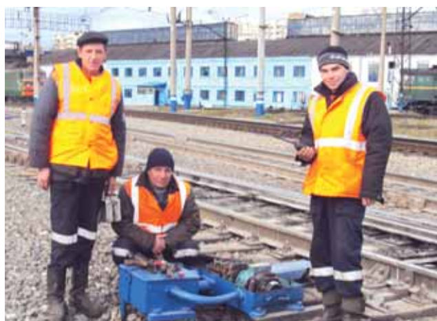
Электромонтеры А.М. Томилин, А.Т. Морозов и электромеханик Д.В. Мерзляков подготавливают электропривод к замене
