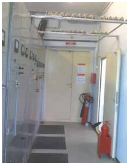
В щитовых установлены системы АПТ, все лампы ПЖ размещены на негорючем основании и вынесены за пределы панелей
