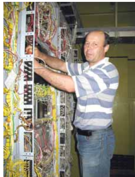
Электромеханик В.И. Пимахин монтирует схему кодирования
