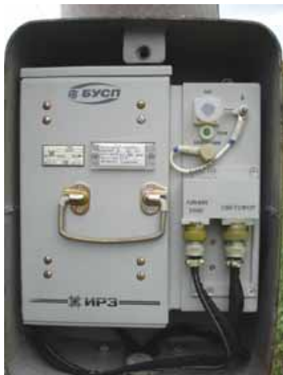
Блок БУСП на мачте светофора
