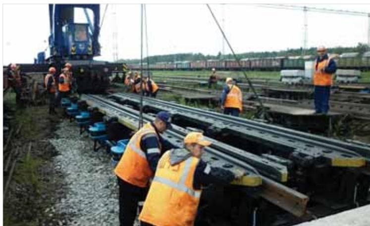
Установка вагонного замедлителя на третьей тормозной позиции на горке станции Бекасово-Сортировочное
