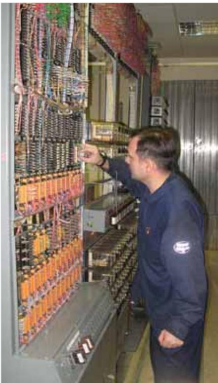
Старший электромеханик КСАУ СП И.П. Самохатка проверяет состояние монтажа матрицы системы
